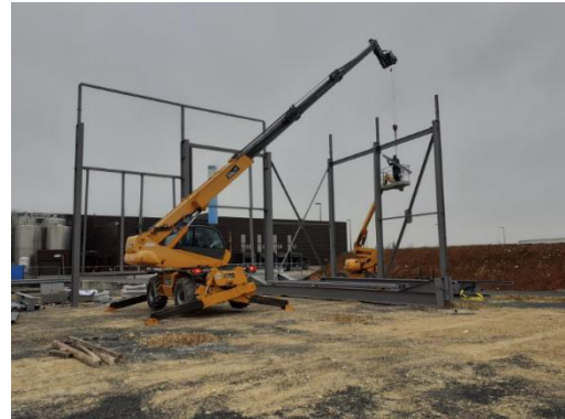
Plateforme terminée déchargement des poutres métalliques début construction (S1 S2)
