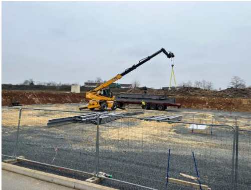
Plateforme terminée déchargement des poutres métalliques début construction (S1 S2)
