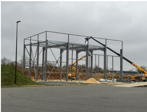
Finalisation de la structure métallique (S2 S3)
